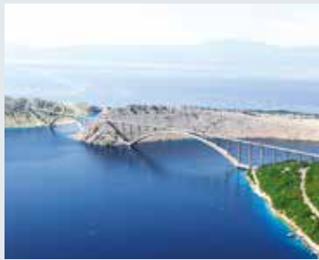
Il ponte che collega Krk alla costa
